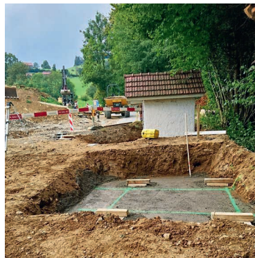
Vor der Versetzung am alten Standort.
