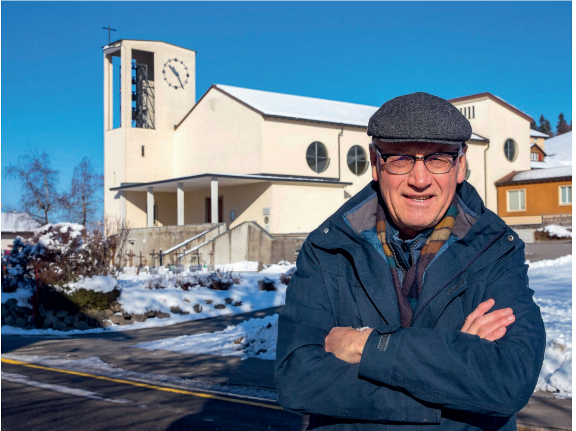
Der Entlebucher Kirchgemeindepräsident Pius Hofstetter vor der Kirche Finsterwald, die mit einer Solaranlage ausgerüstet wird. Das ist dort möglich, weil der Bau nicht denkmalgeschützt ist.
